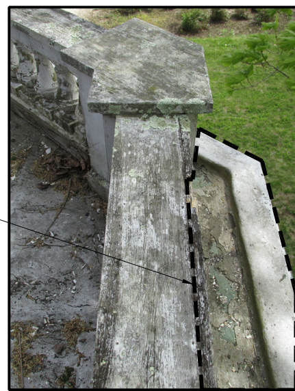
TYP. BALCONY GUTTER DEMO
